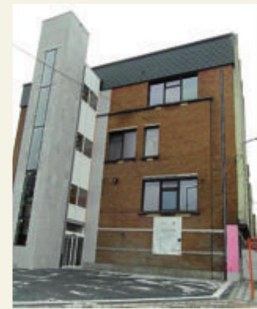
▶ Les travaux s'achèvent. © ALBIN
